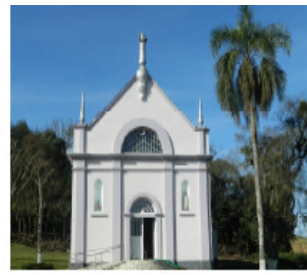
Capela Nossa Senhora dos Campos
